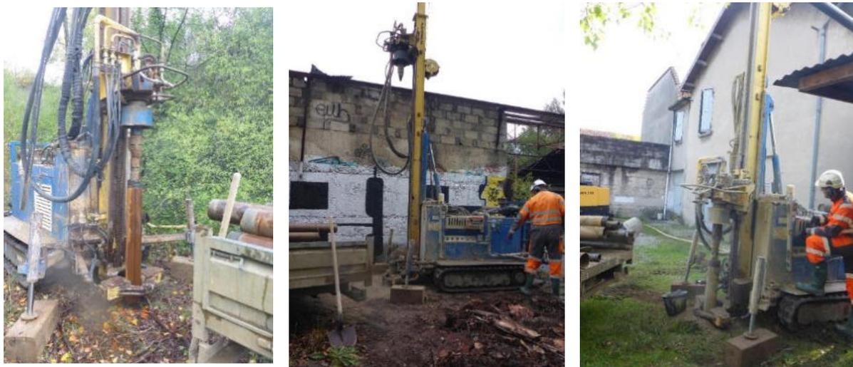
Foration du piézomètre G1 Foration du piézomètre G5 Foration du piézomètre G9
