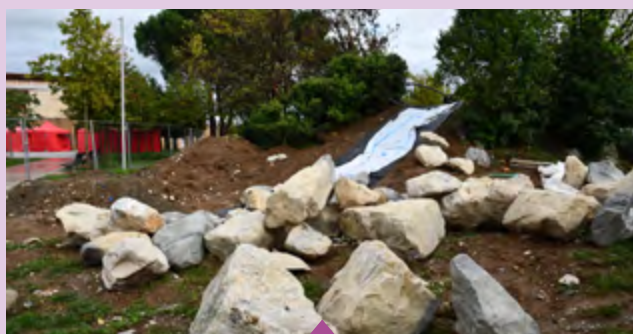
Octobre – Travaux en cours de la future cascade de l'Île-parc Girodet
