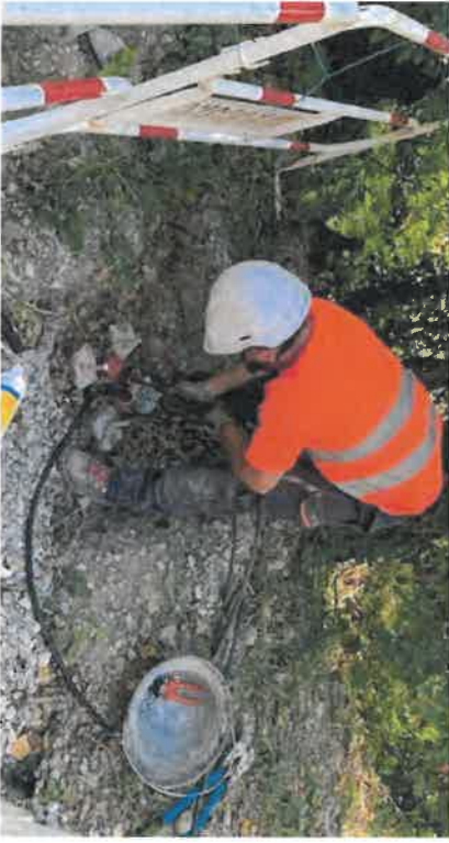
Cablage d'un futur mat d'éclairage public à Rémuzat
