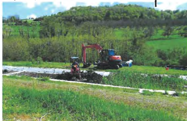
Curage du filtre planté de roseaux de Saint-Bonnet-de-Valsclérieux à Volherbasse
