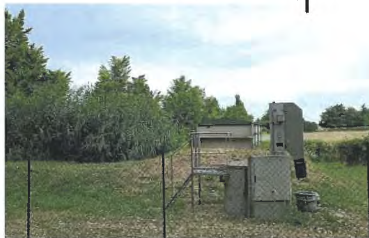
Biodisques et filtres plantés de roseaux de Charpey
