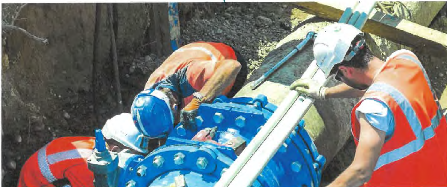
Travaux de renouvellement de vanne sur une canalisation de transport d'eau
