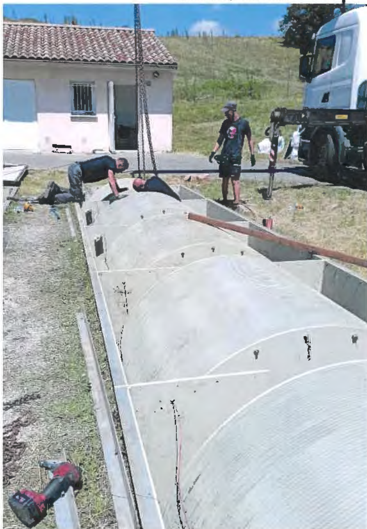
Travaux sur la ligne de biodisque de Barbières
