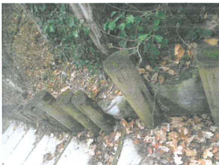
Côté garde-corps, nous relevons que les potelets en bois se sont écartés des dalles béton. Nous relevons qu'un visse permettait une liaison entre les potelets et les dalles béton, nous remarquons que ces visses se sont complètement oxydées.
