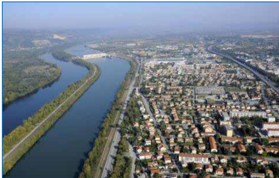
Bourg-lès-Valence: Le Rhône naturel / Le Canal / la RD2007 / le quartier des Chirouzes / l'A7
