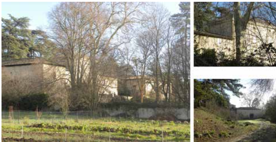
Maison de campagne de la Tourtelle
