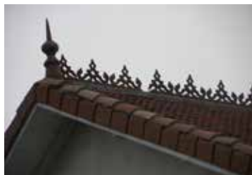
Détail de la toiture
